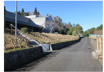
⑯ 前庭・下水道管理用道路
